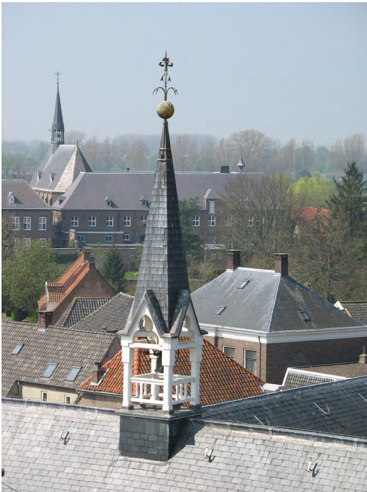
Figuur 81. De skyline van Megen wordt bepaald door markante kloosterarchitectuur (foto MAB, 2007).
